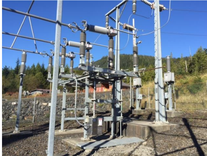
CS-T36 New Circuit Switch
